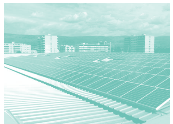
Sur le toit d'Aurubis, la centrale solaire participative permettra de produire annuellement 90'000 kilowattheures.
