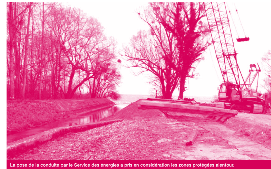
La pose de la conduite par le Service des énergies a pris en considération les zones protégées alentour.
