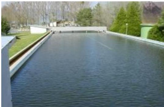
Le deuxième décanteur est de forme rectangulaire, pouvant contenir un volume de 2700 m<sup>3</sup>
