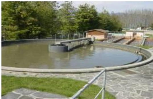
Le décanteur est de forme circulaire, d'une capacité de 700 m<sup>3</sup>. Un racleur de surface élimine les matières flottantes (huiles, graisse, plastique...) et un racleur de fond dirige les boues primaires au centre de l'ouvrage d'où elles sont extraites.
