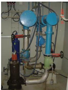
Le rôle de la station de pompage ou de relevage est de fournir la hauteur d'eau nécessaire au traitement gravitaire.
