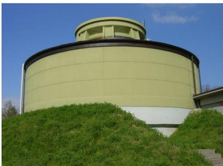
Les boues à la sortie de l'épaisseur-stockeur sont introduites dans le stockeur, d'un volume total de 1700 m<sup>3</sup>.
