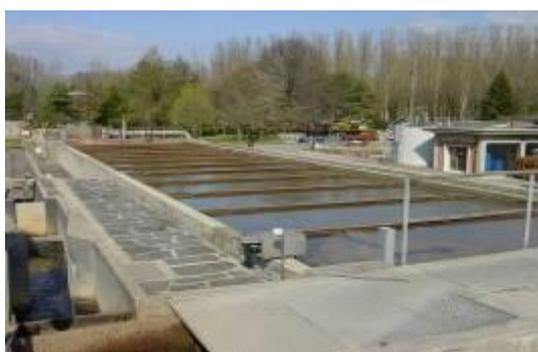
Le décanteur est de forme rectangulaire, d'un volume de 1200 m<sup>3</sup>. Le bassin est équipé de deux trémies en amont, qui permettent de récupérer les boues déposées dans le fond grâce à un système de racleurs à chaîne. Ce type de racleur permet également de récupérer les matières flottantes.
