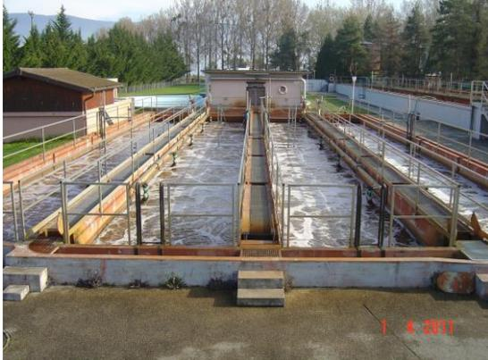
Le traitement se réalise dans quatre bassins parallèles, d'un volume total de 700 m<sup>3</sup>.
