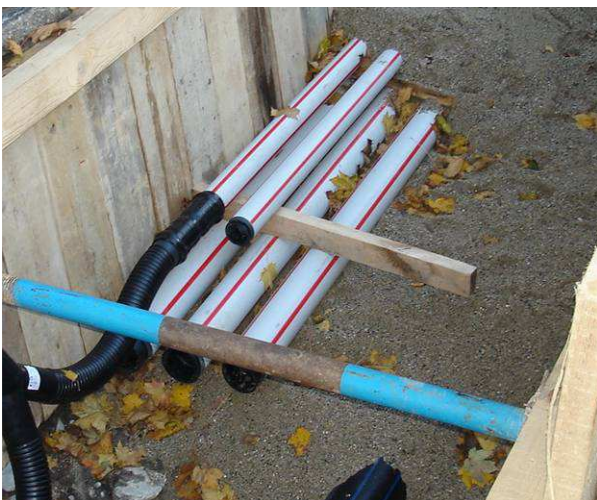
Ecartement vertical des tubes de protection
