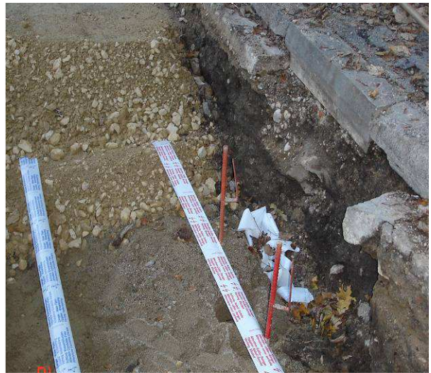
Maintien des tubes par fiches métalliques
