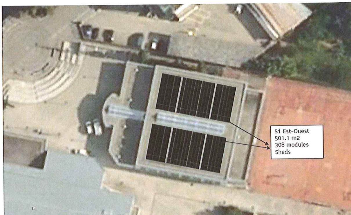
Fig.4 : Salle de gym de la Marive : Implantation de 308 modules en mode est-ouest
