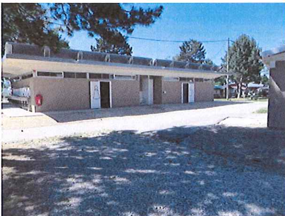
Vue arrière du nouveau bloc sanitaire et chemin en enrobé bitumineux en traversée.
